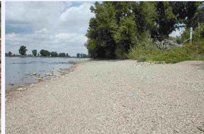
Entfernen der Ufersicherung im NSG „Ballauf-Wilhelmswörth“ (Oberrhein)
